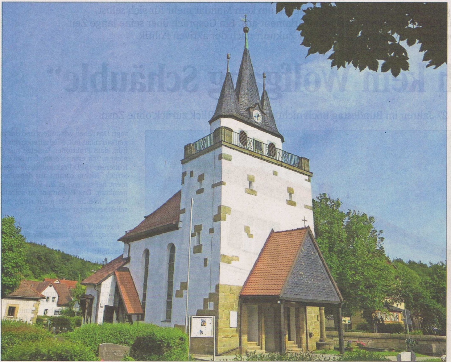
Evangelisch-lutherische Bartholomäuskirche in Glashütten.
